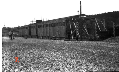
Construction of kitchen block, spring 1940 (Museu d'Història de Catalunya, Fons Amical de Mauthausen)
