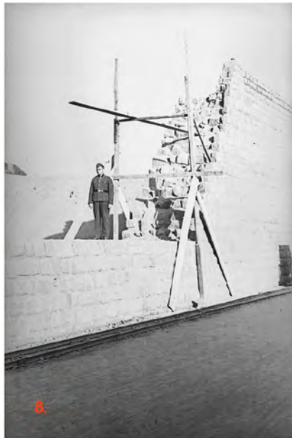
Northern retaining wall, probably spring 1943 (Museu d'Història de Catalunya, Fons Amical de Mauthausen)
