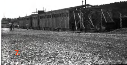
Kitchen barracks under construction, spring 1940 (Museu d'Història de Catalunya, Fons Amical de Mauthausen)
