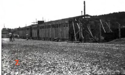
Küchenbaracke im Bau, Frühjahr 1940 (Museu d'Història de Catalunya, Fons Amical de Mauthausen)
